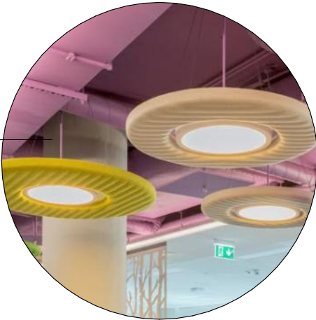
Baffles acoustiques suspendues Coloris et teinte assortis à la DA générale (sans éclairage)
